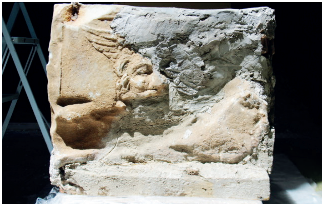
▲ Fig. 2 - ARICCIA, Villino Volterra. Prospetto laterale destro prima dell'intervento
