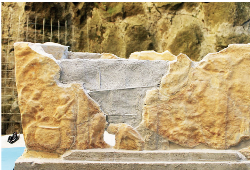
▲ Fig. 4 - ARICCIA, Villino Volterra. Struttura di sostegno (rete in acciaio e perni in vetroresina)
